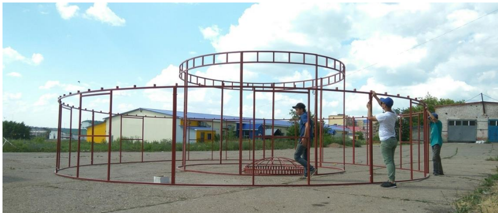
3. Фотографии каркаса в процессе сборки (без купола и стропил):
